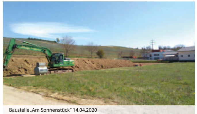
Baustelle „Am Sonnenstück“ 14.04.2020
