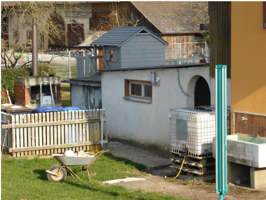
Nebengebäude an der Westlichen Ortsumgehung
