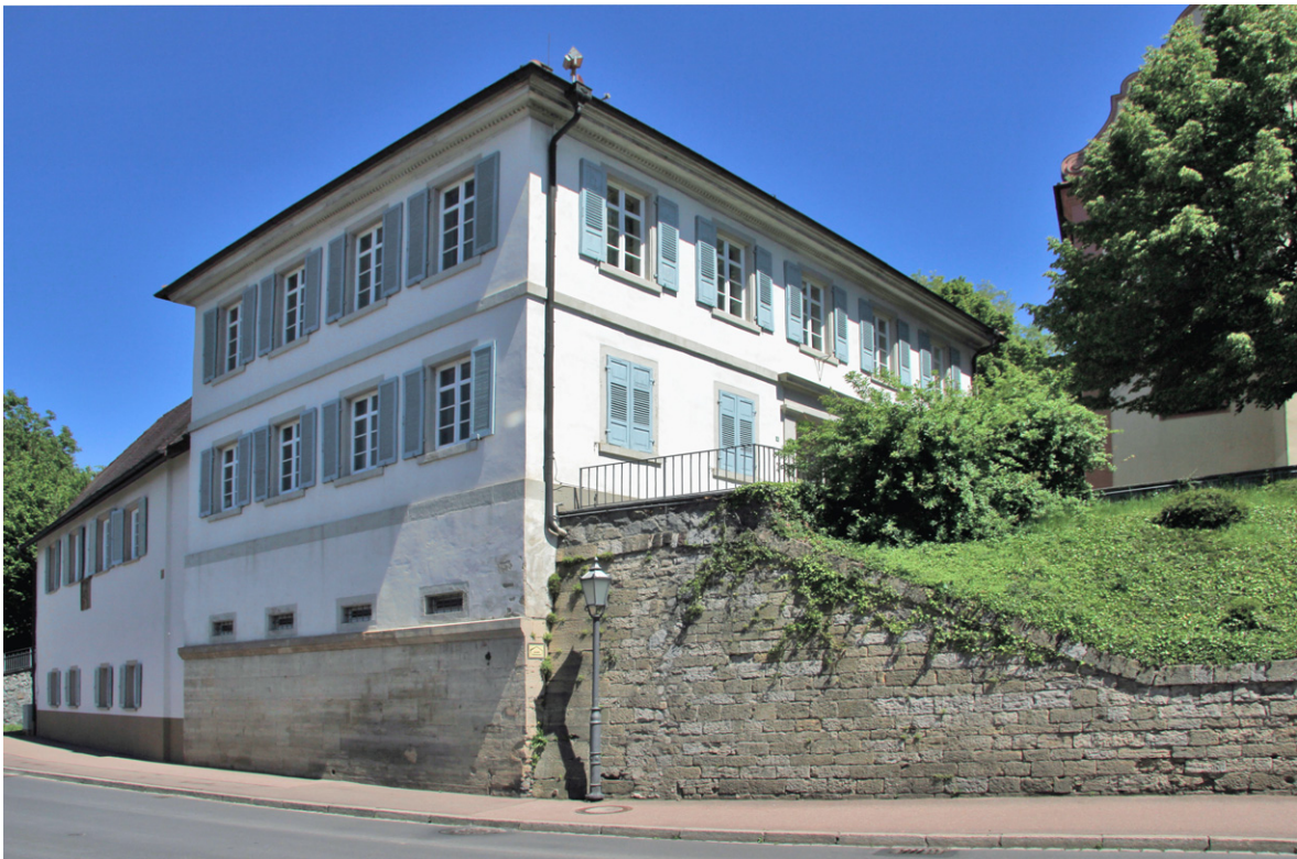
ABBILDUNG 9: Haus am Immissionsort 1, das Niveau EG ist als Kellergeschoss genutzt.
